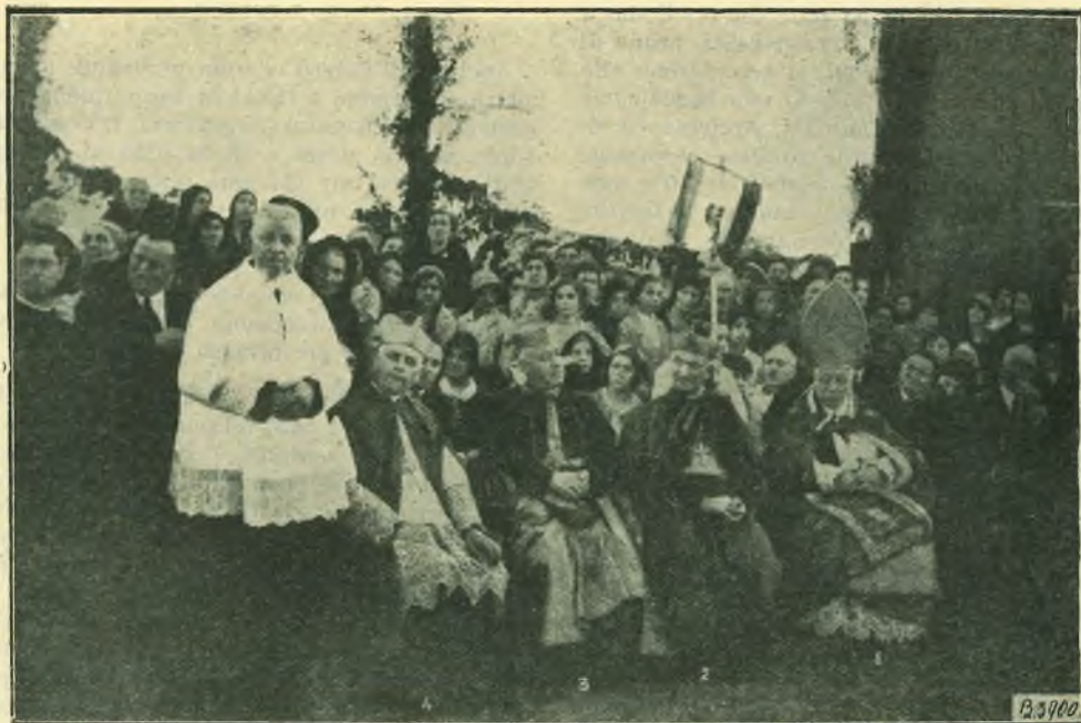
Brindisi — Posa dell'a prima pietra delle Opere Salesiane. — Durante il discorso dell'Ispettore D. Simonetti.
