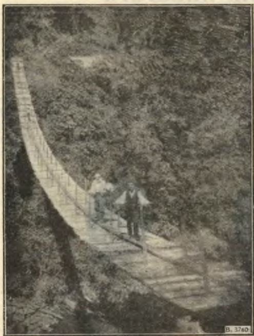
Mendez. — Ponte sospeso sul fiume Namangosa. Opera salesiana: lung. m. 86, alt. m. 48, largh. m. 6.
